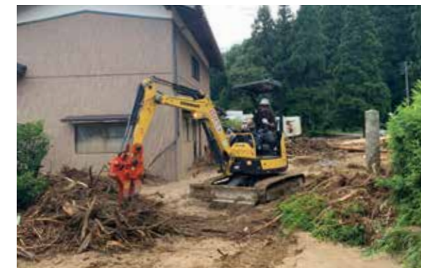
流木などの撤去(新潟県村上市花立地区)
