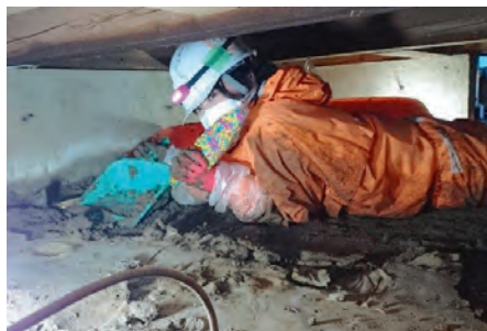
床下の泥だしの様子
