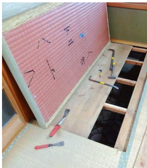
和室の床板をはがす（写真①）
