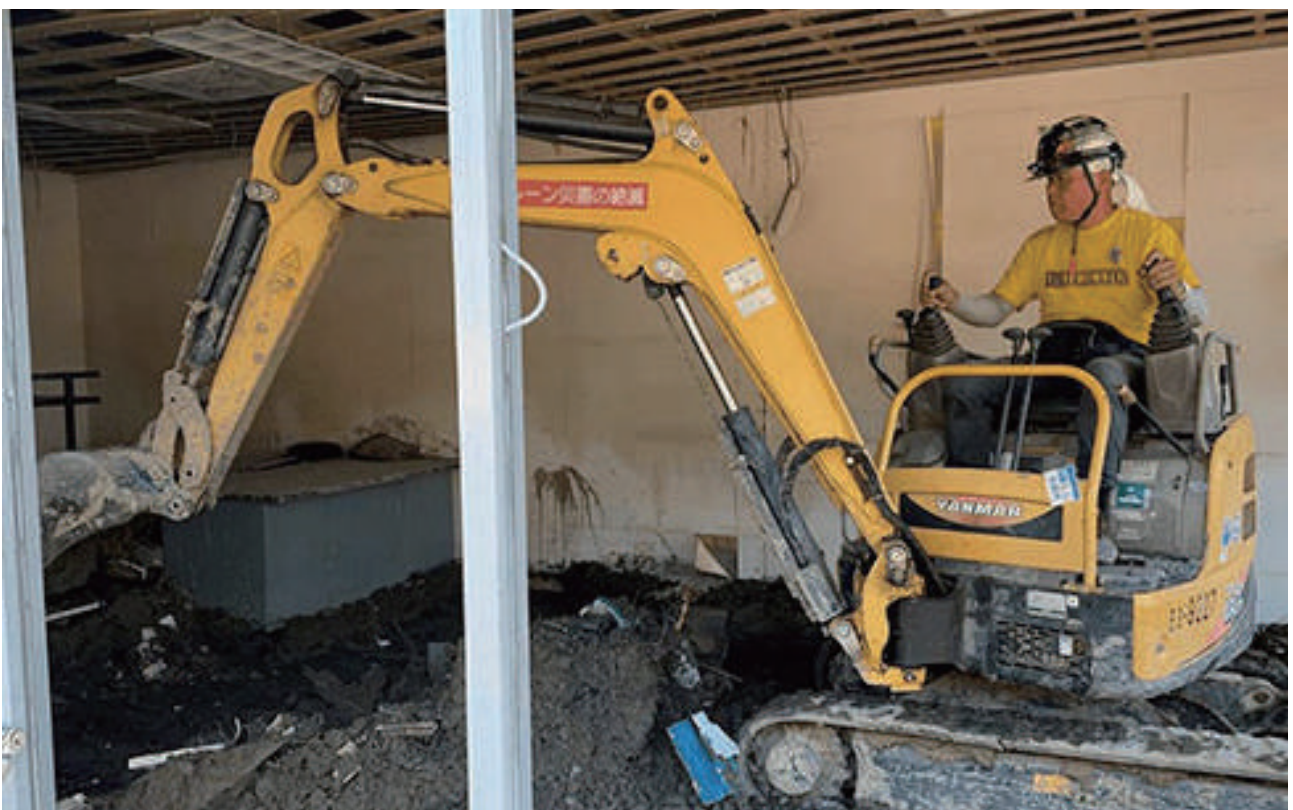
被災地支援における重機の重要性
