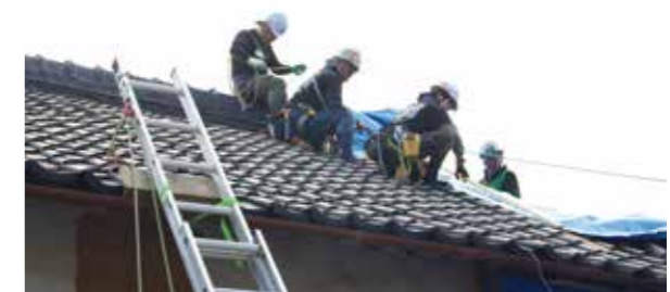
屋根修繕の作業をするボランティア(大阪府茨木市)
