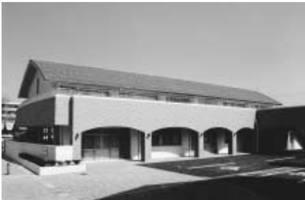
パン工房と喫茶店を備えた施設外観
